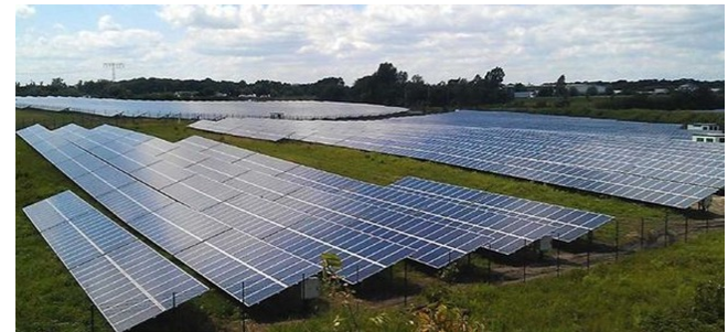
Panneaux solaires photovoltaïques - Ibvogt
